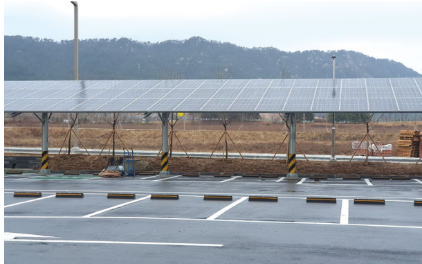
예산홍성사옥 신재생에너지 설비 공급 비율 32%(주차장 PV)
